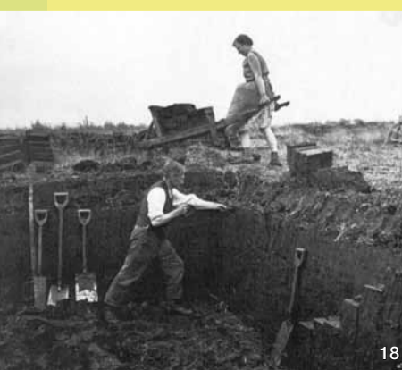
◀ Bei der Brenntorf-gewinnung löste man mit verschiedenen Torfspaten und Torfstechern („Steker“) die über ziegelsteingroßen Torfsoden von der Bank ab.
