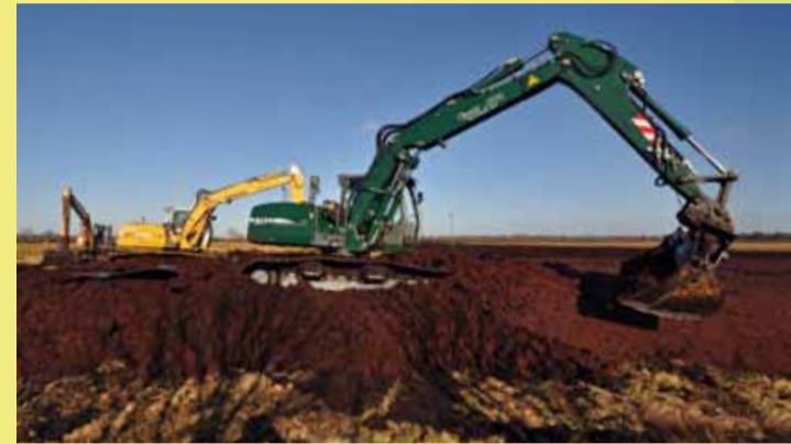
▲ Bagger beim Aufsetzen der Verwallungen
