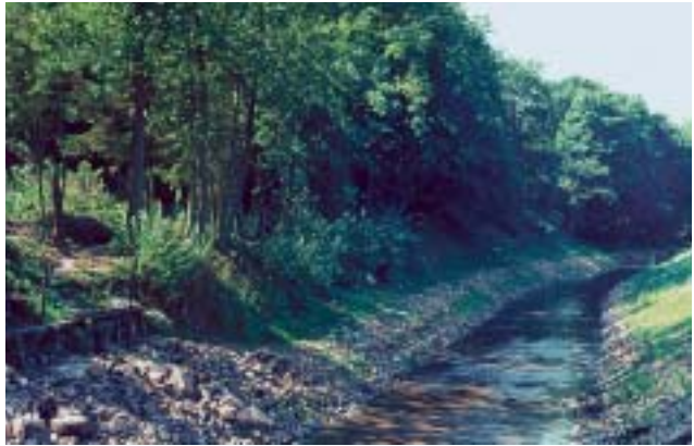
Abbildung 15: Gewässerausbau 1975. Solche Maßnahmen gehören in Schleswig-Holstein der Vergangenheit an.
