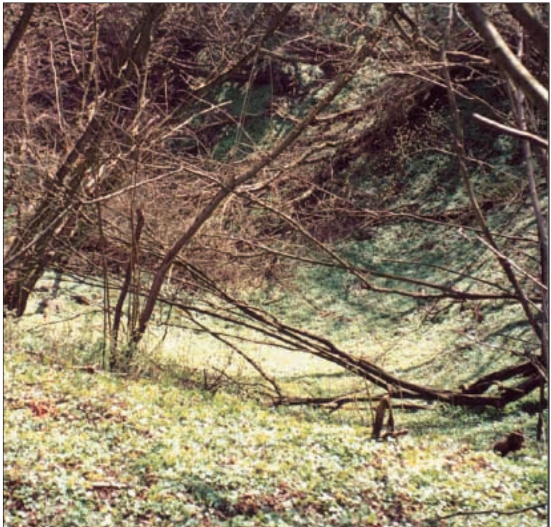
Abbildung 5: Erdfall bei Stipsdorf östlich Bad Sege- berg. Bis etwa 20 Meter langer ovaler Einsturz, mit Feld- steinen und ande- rem Material ver- füllt. (Foto: H. Weinhold)
