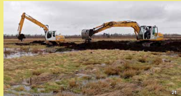
Nach Abtragen der stark vererdeten obersten Bodenschicht schaffen Bagger durch den Bau von Verwallungen die Grundlage zur Wiedervernässung des Königsmoores.
