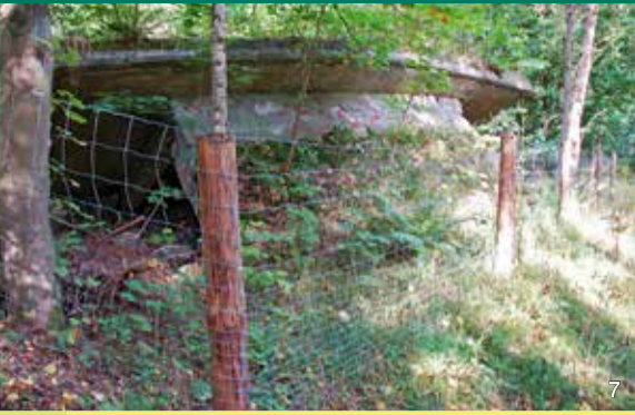
Im Gelände verteilt finden sich noch heute Reste einer ehemaligen Munitionfabrik. Die Ruinen sind z.T. einsturzgefährdet. Ein Betreten ist daher untersagt.
